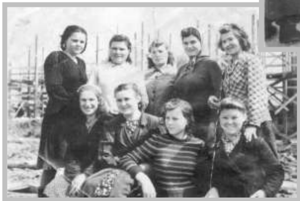
Бригада строителей- отделочников. Кингисепп конца 50-х годов.
